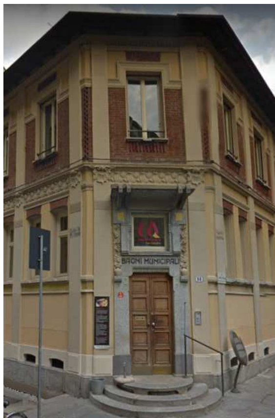
Edificio dei bagni municipali a Torino in stile liberty di recente restauro.
