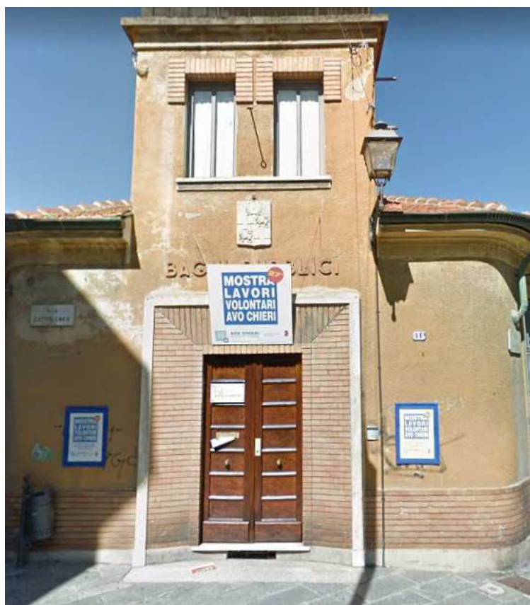
Vecchio edificio dei bagni pubblici a Chieri in via Balbo.
